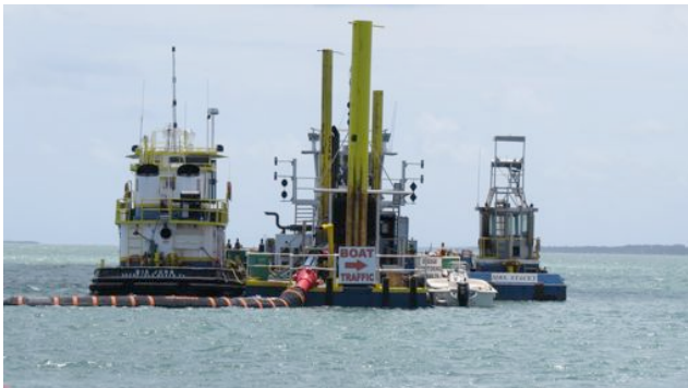
Ausbaggern der Fahrinne
