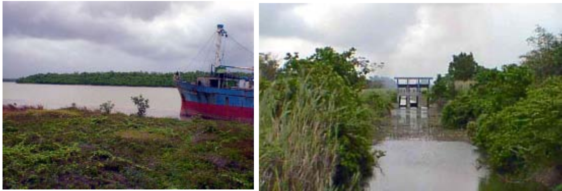
Foto 1.3.6 . Lokasi outlet drainase utama S. Maro dan Pintu Air PA-3
