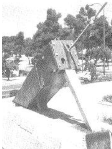
Figura 1.26 Fijación al suelo por gravedad
