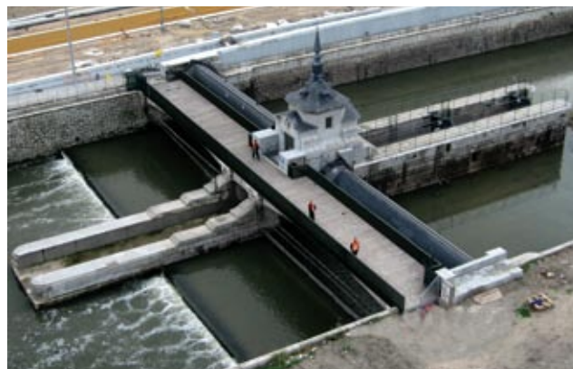
Presa nº 8 antes y después de la actuación.
