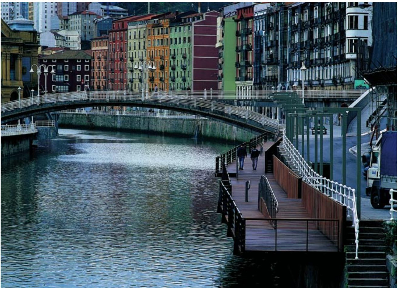
Área de Rehabilitación Integrada de Bilbao la Vieja a orillas de la ría del Nervión. Bilbao. (Fotografía cedida por BILBAO Ría 2000).
