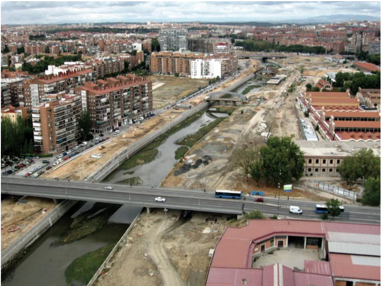
Puente de Praga al fondo, Puente del Invernadero (en construcción), Puente del Matadero (en construcción) y Puente de la Princesa en primer término.
