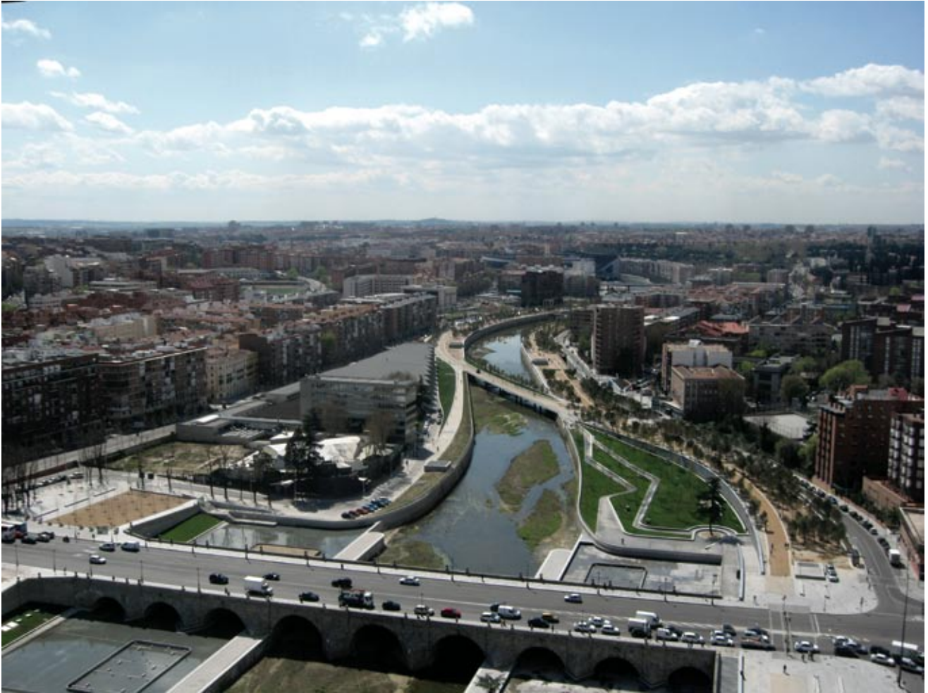
Rehabilitación del Puente de Segovia y su entorno.
