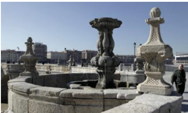
El Puente de Toledo después de las obras de rehabilitación. Diciembre 2009.
