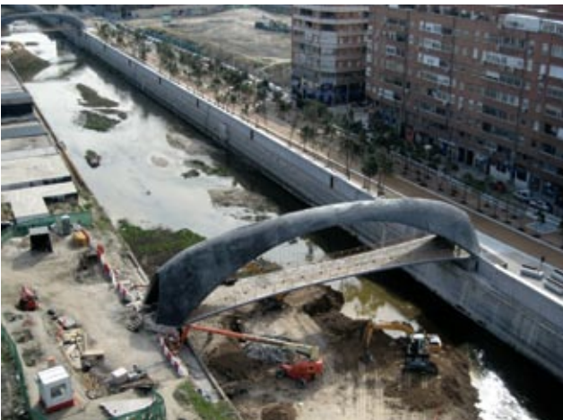
Puente del Invernadero en primer término y puente del Matadero al fondo, ambos en construcción.
