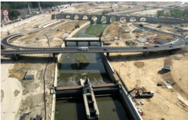
Presas nº 7, puente rodado, pasarela norte y Puente de Toledo.
