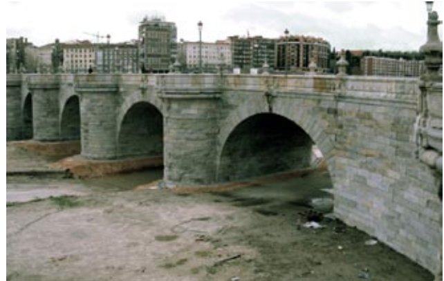
Puente de Toledo antes y después de la actuación.
