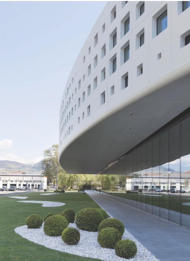
Insgesamt 842 Fensterelemente perforieren die pulverbeschichtete Metallfassade.
