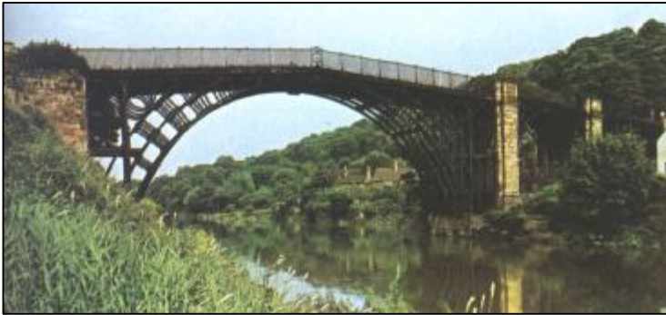
11. Puente de hierro de Coalbrookdale. 1777.
