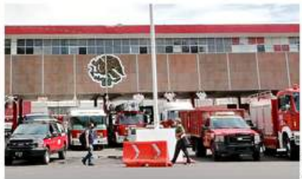
La zona de dormitorios de los bomberos en la Estación Central, tiene daños estructurales desde el 19S.
