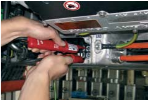
Bild 3: Spannungsfreiheit feststellen
