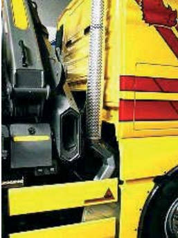
Abb. 32: Berührungsschutz an einer Auspuffleitung
