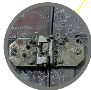
Посилені петлі дверей Reinforced door hinges
