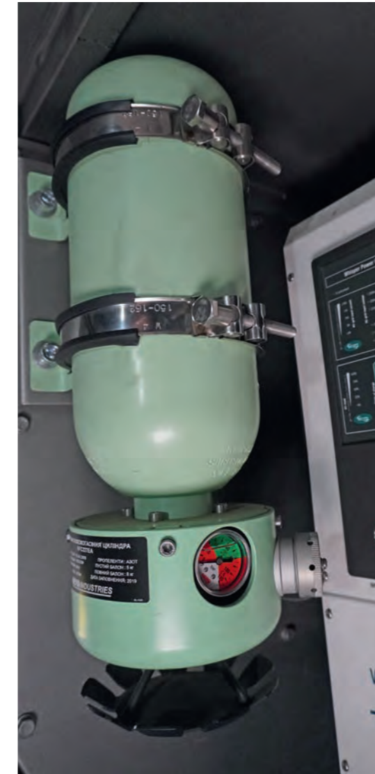
Автоматична система пожежогасіння (опція) Stand-alone fire suppression system (optional)
