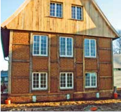
Das Fachwerkhaus kurz nach der Renovierung.
