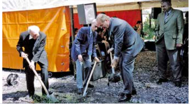
Dechant Heinz Booms, Superintendent Erhard Nierhaus und Oberbürgermeister Thomas Hunsteger-Petermann vollziehen den ersten Spatenstich.
