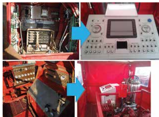
Рисунок 5 – Установка нового пульта управления
