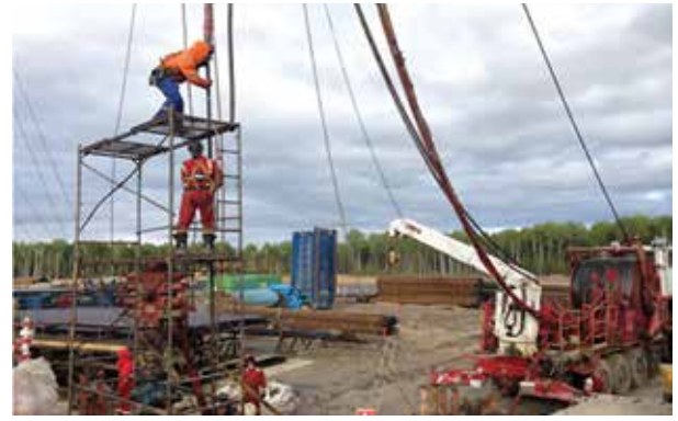
Рисунок 1 – Подготовительные работы к спуску перфоратора на гибкой трубе на скважине № 3030Г куст № 1 месторождения им. Малыка
