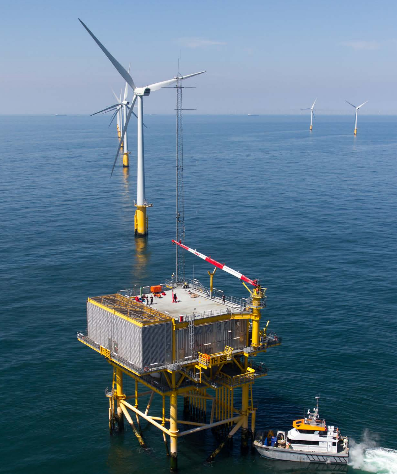
Thanet Offshore Wind Farm — Courtesy Vattenfall
