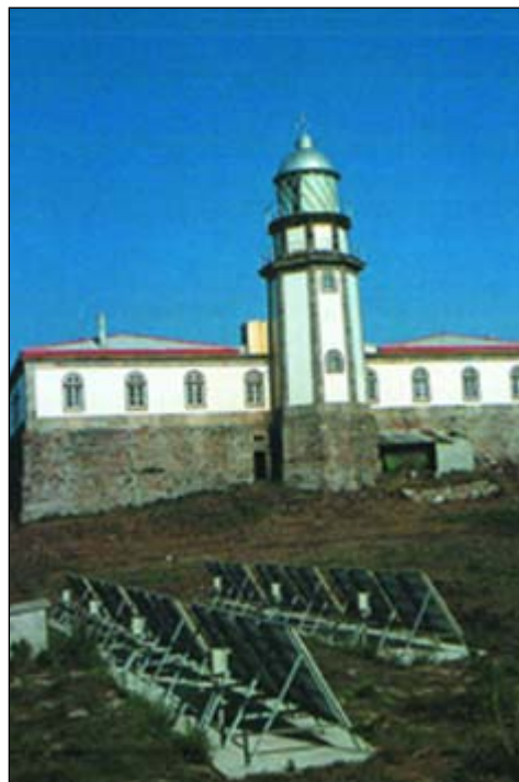
O faro da Illa de Ons funciona con enerxía fotovoltaica
