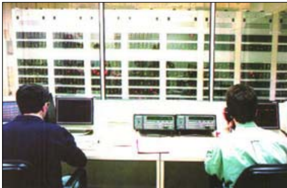
Redes de telecomunicacións
