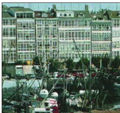
Galerías coruñesas, un exemplo do aproveitamento do calor
