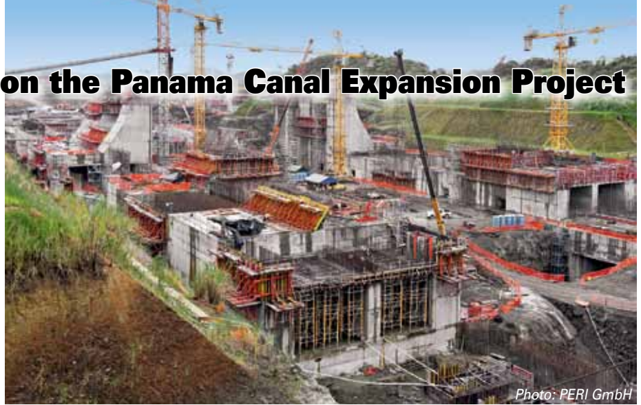
Photo: PERI GmbH
