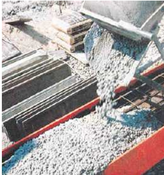
Fig.4.3 – Betonagem horizontal de um pilar parcialmente revestido [15]
