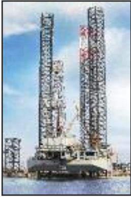
Keppel AmFELS pages 6 - 8
