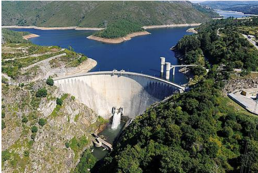
Fig.4 – Barragem Alto do Lindoso
