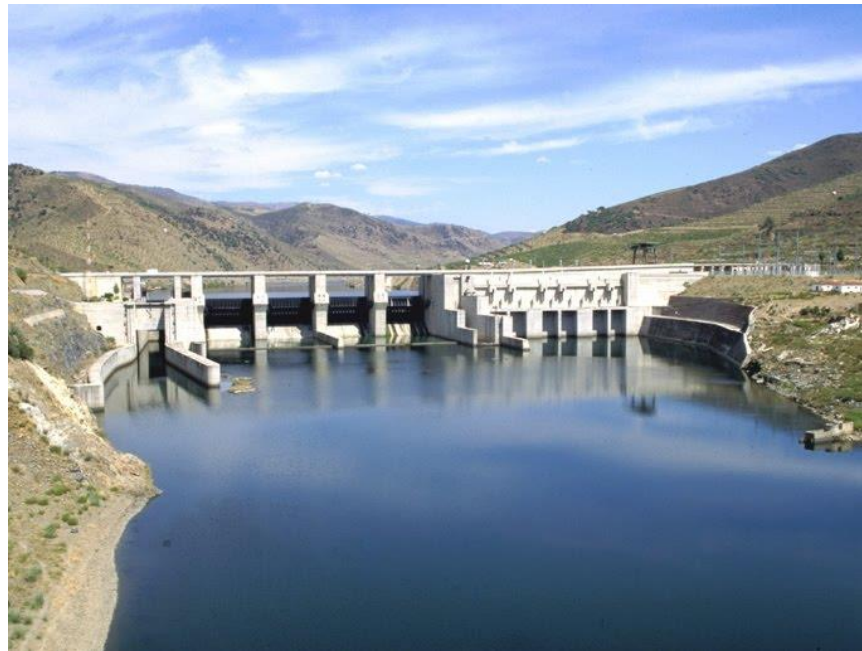
Fig.3 – Barragem a fio de água do Pocinho
