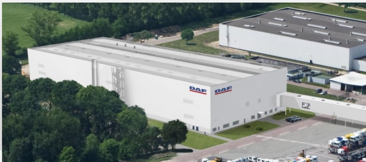
DAF cuarto de Pintura, Westerlo, Bélgica
