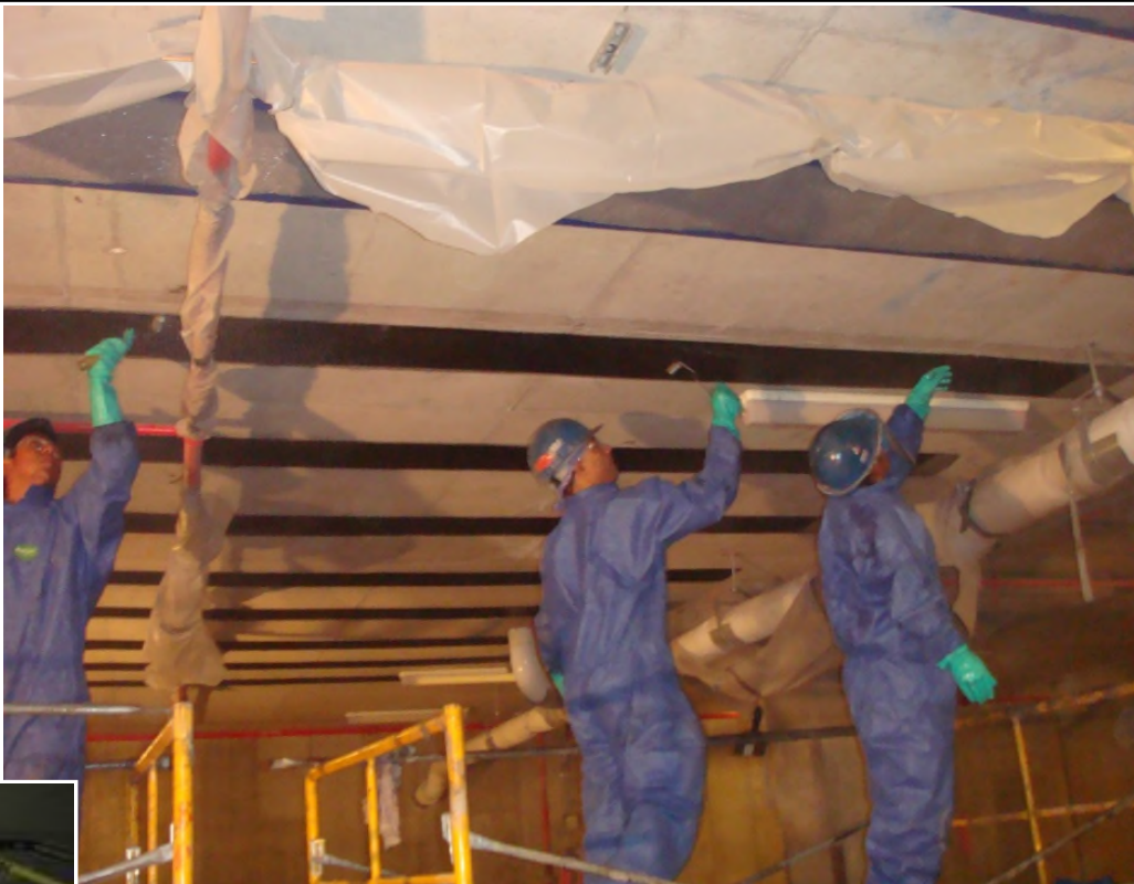
Varillas de FRP en ranuras
