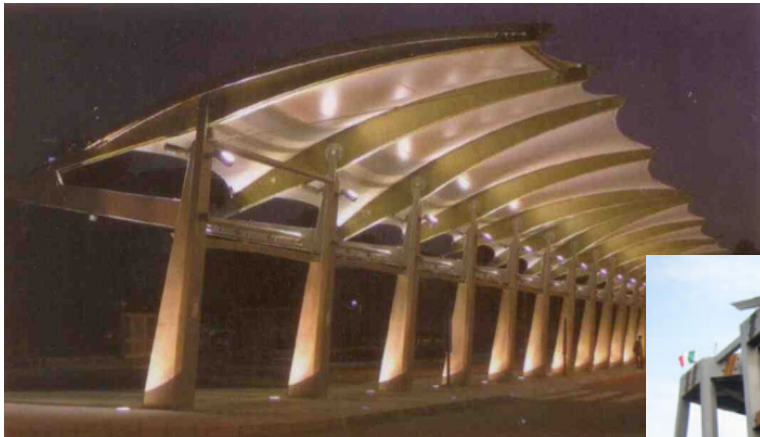
Auvent de la Gare Routière – Ermont
