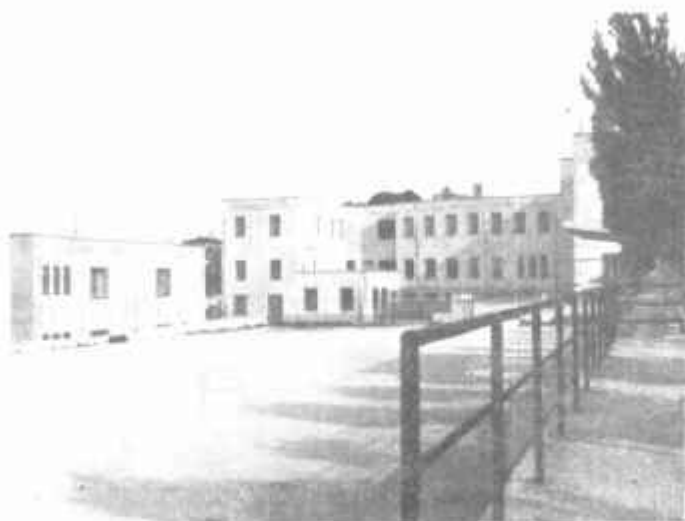
Istituto "Felice Ventura" - Campo sportivo e veduta parziale dell'edificio
