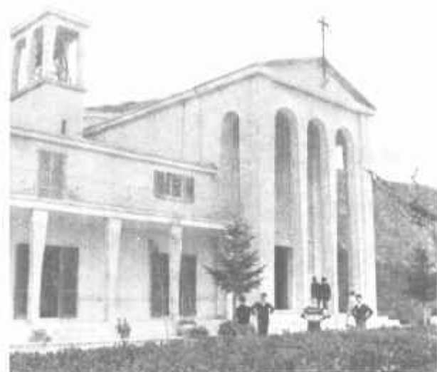
(L'Aquila) — Casa dei Discepoli — L'Abbruzzo
