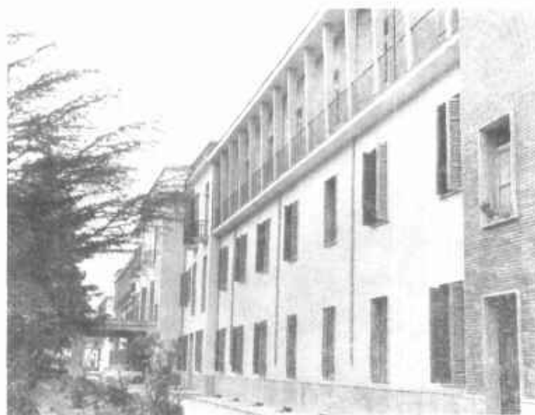
Potenza Istituto "Principe di Piemonte" Veduta parziale della lunga facciata.
