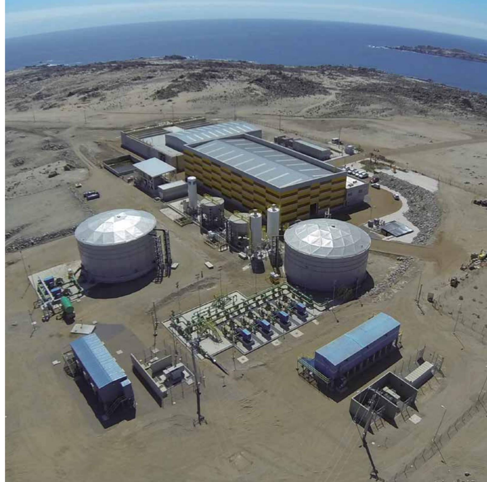
Copiapó Desalination Plant, Chile
