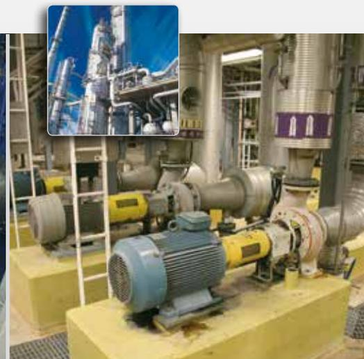
Easy-Laser® permite alinear bombas y motores de todo tipo de máquinas de diversas industrias. Las máquinas deben estar correctamente instaladas y alineadas para reducir el consumo de energía y lograr una vida útil óptima.
