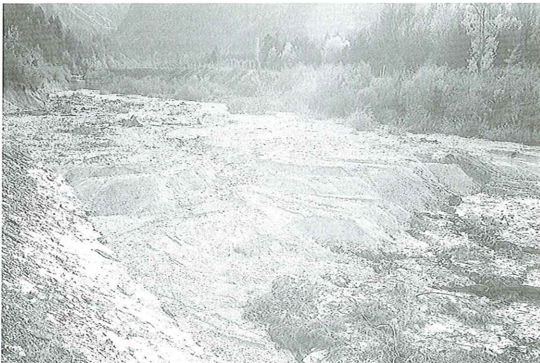
56 Foto 1 - Deposito a monte della briglia aperta sul rio Valscura nel comune di Caldonazzo (TN).
