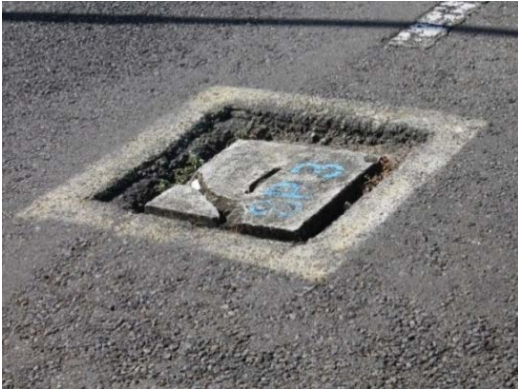
Gambar 3 (a) Piezometer pada Bendungan (Departemen Pekerjaan Umum, 2015)
