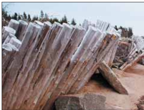
Les murs en bois résistent mal lorsque soumis à des vagues de forte intensité.
