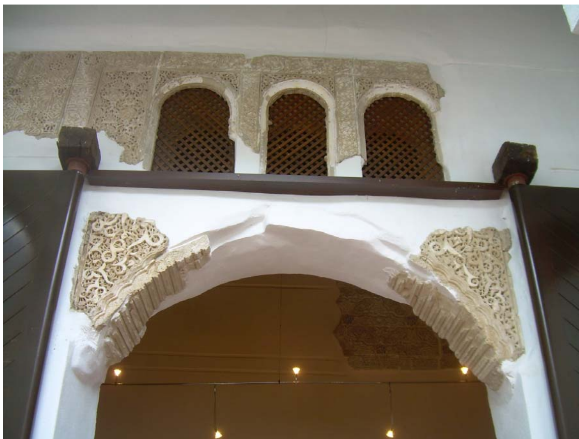
Arco de acceso al salón principal con alhanías de la Casa del Gigante (Ronda, Málaga)
