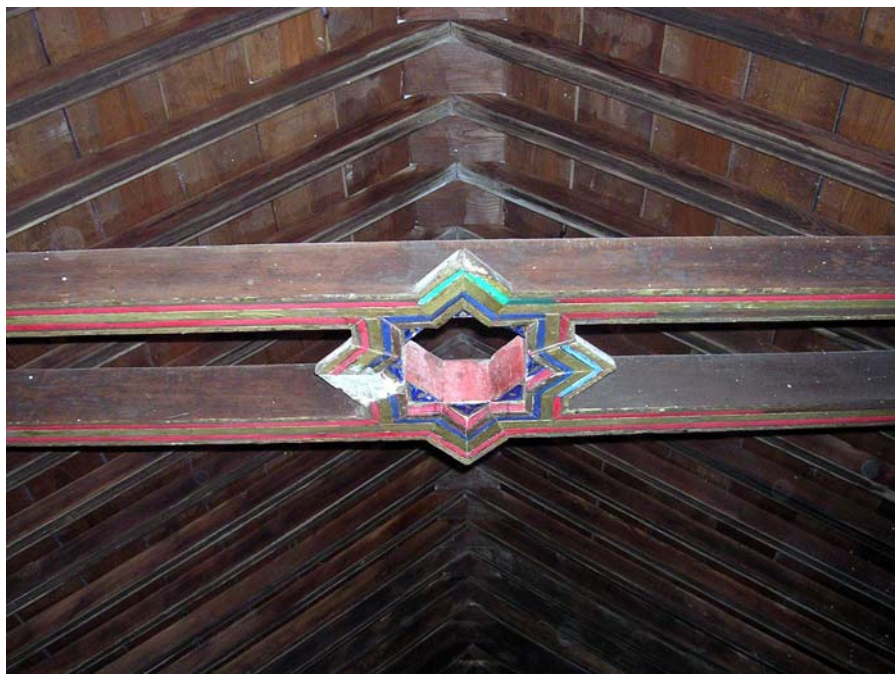
Armadura del salón superior de la casa morisca de calle Pardo n° 5 (Granada)
