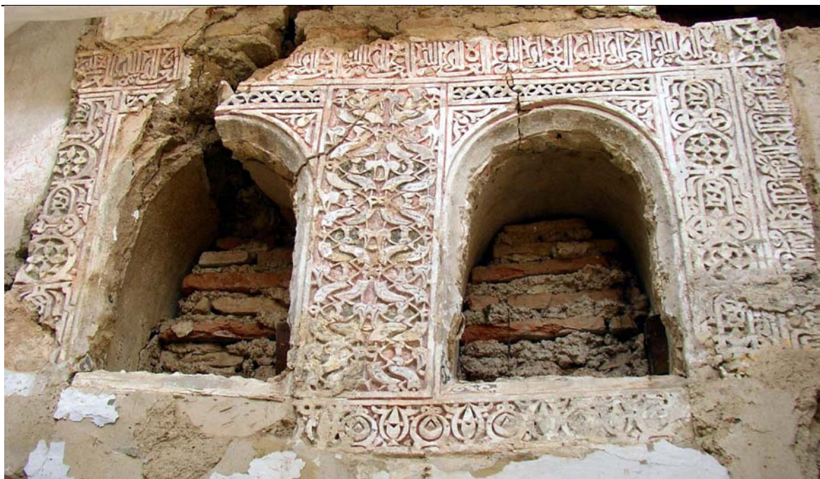
Yeserías de la Casa de Yanguas (Granada) [Fotografía del LAAC].
