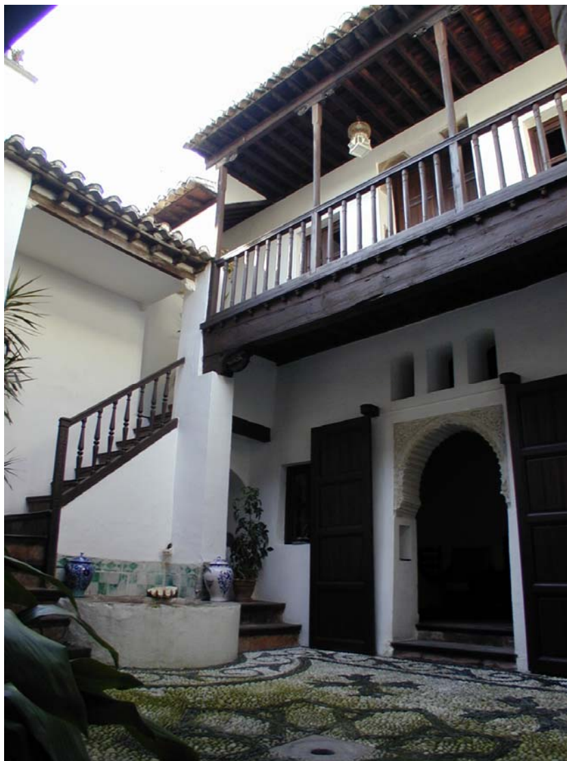
Patio de la casa morisca del Callejón de San Luis Alto (Granada)
