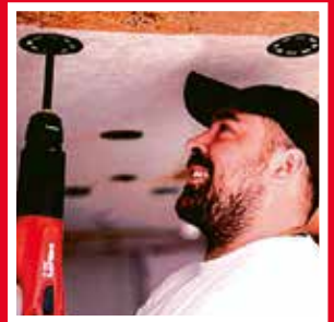
Isolation des sous-sols
