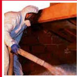
Isolation des combles
