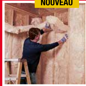
- Du logement en rénovation - Du mur intérieur du garage mitoyen de la maison
