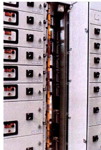
Se prohíbe el uso común del mismo colector para funciones de protección (tierra) y funciones de neutro. El colector de tierras debe ser perfectamente identificable y distinto de cualquier otro colector.
