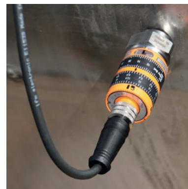
Sensor position on fan casing. (A2 : VKV 021)
