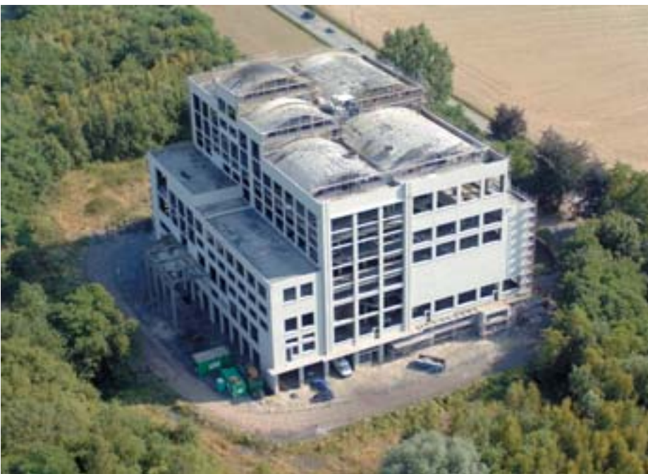
Vue aérienne du triage-lavoir, F. Dor, DOHC © MRW
