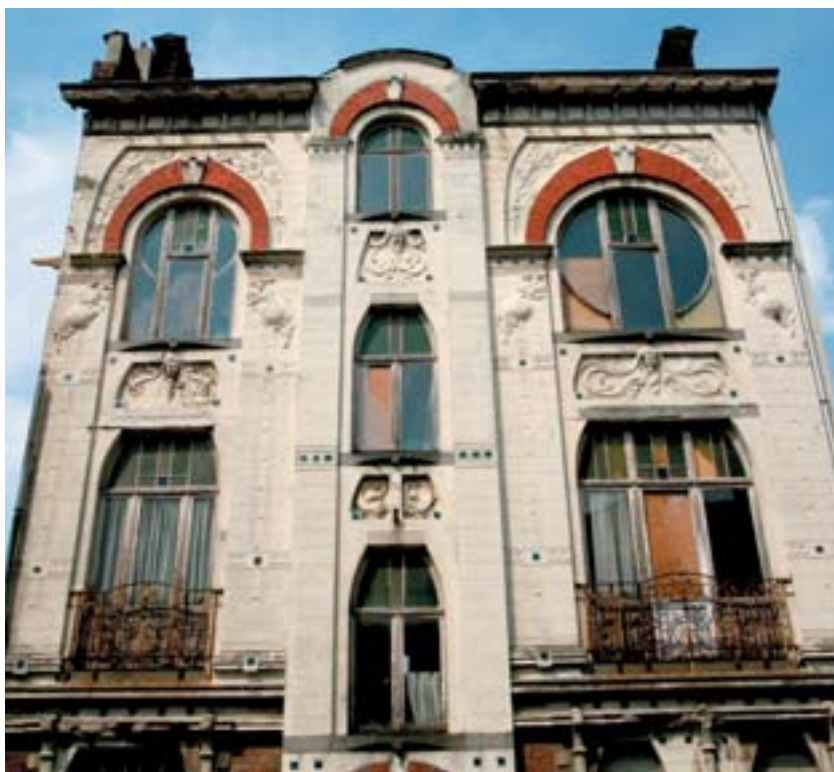
Façade de la Maison Bauwens © Alain Boos
