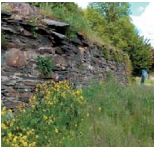
Mur de soutènement à Paliseul © IPW
