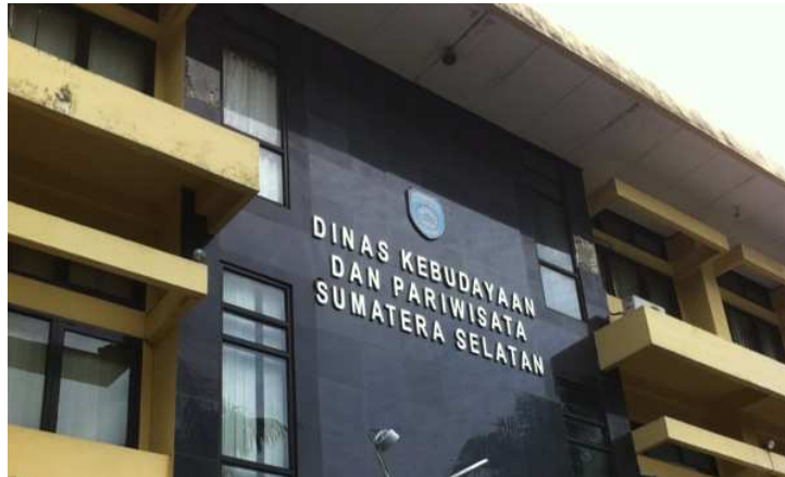
Gambar 2.1.3.1 Gedung Dinas Kebudayaan dan Pariwisata Sumatera Selatan Sumber: Dokumen Penulis (2015)
