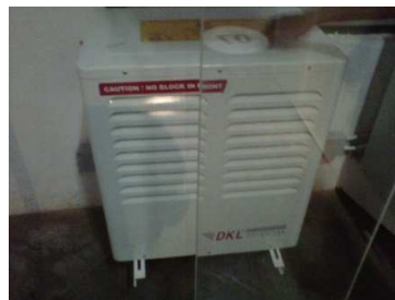
Gambar 2.5 Alat Pemadam Kebakaran (1)
