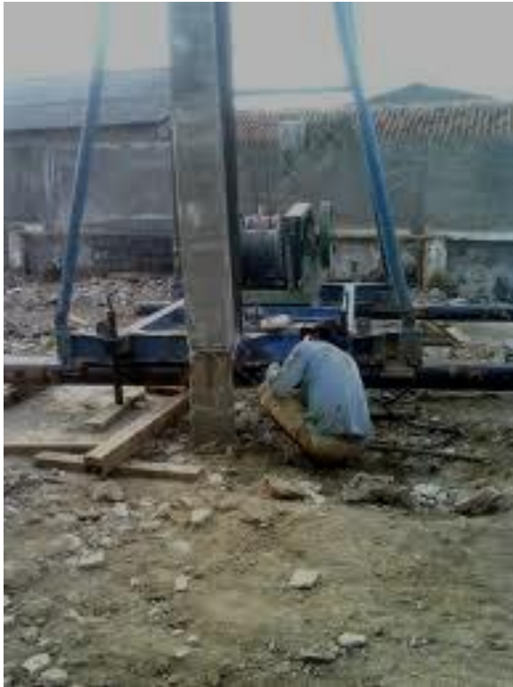
PENYAMBUNGAN PONDASI TIANG
