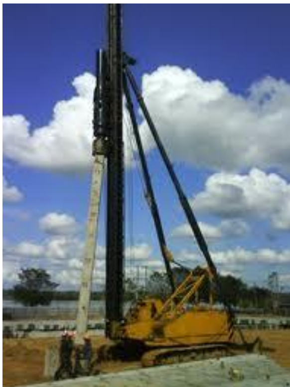
BLOK HAMMER PONDASI TIANG
