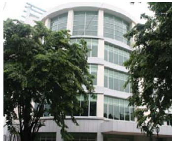
Gambar 25. Gedung Pusat Operasional InaTEWS
