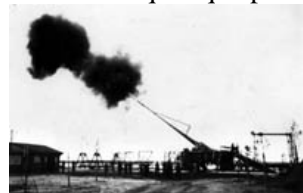
Le canon qui bombardait Paris (1918) : longueur 36 m, poids 750 t, calibre 210 mm, obus 104 à 106 kg, vitesse d'éjection 1600 m/s, portée 126 km !
