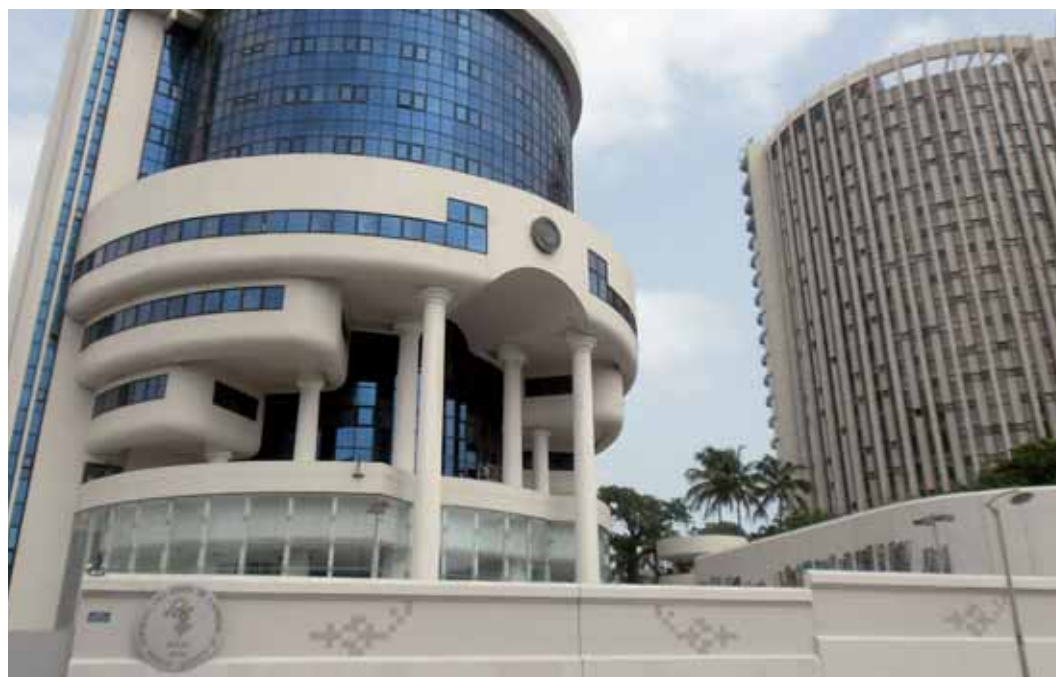
Annexe du siège de la BCEAO à Dakar
