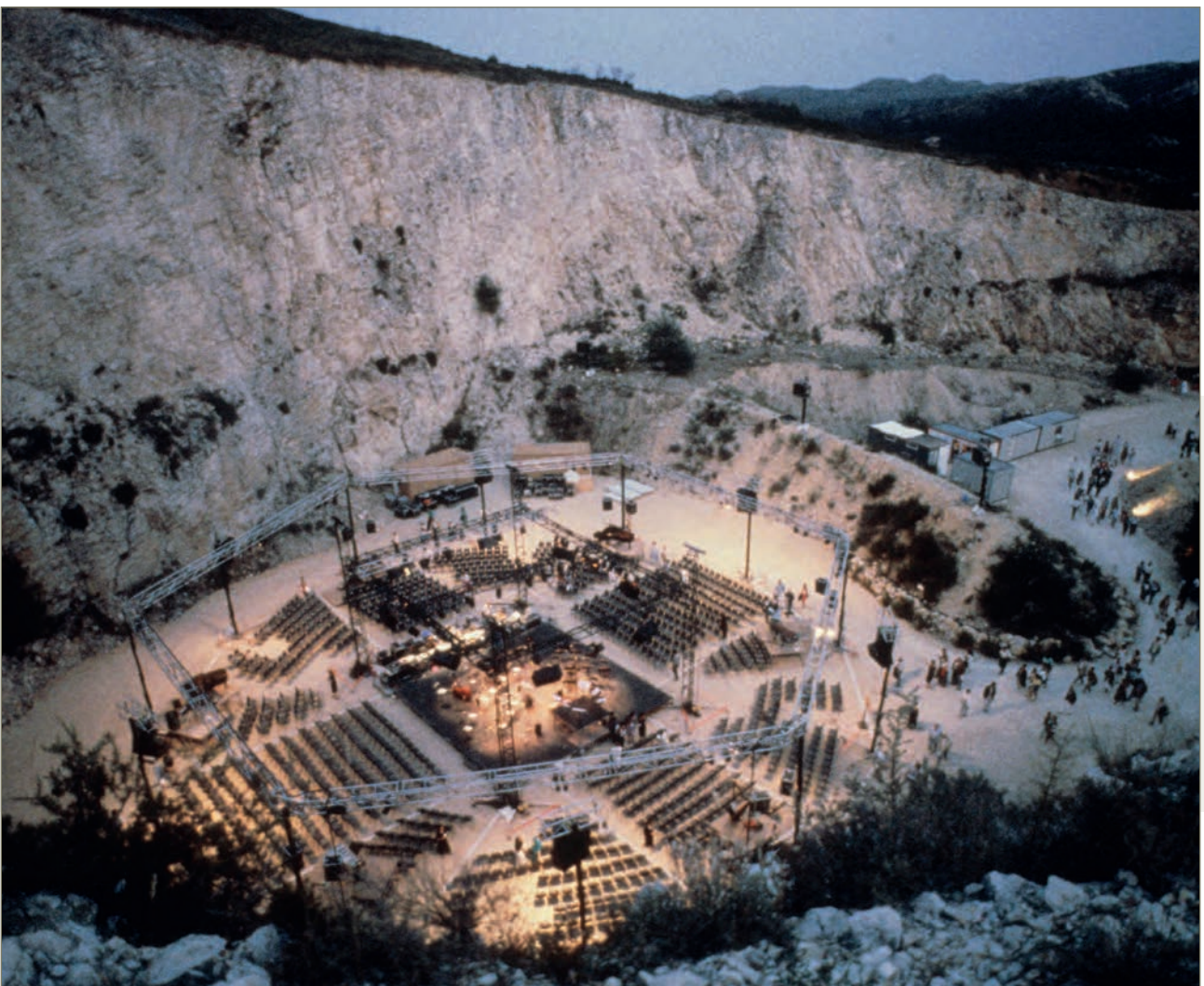
Dominique Darr, Installation du dispositif de Répons , carrière Callet, Boulbon, Avignon 1988. Archives Ircam – Centre Pompidou.
