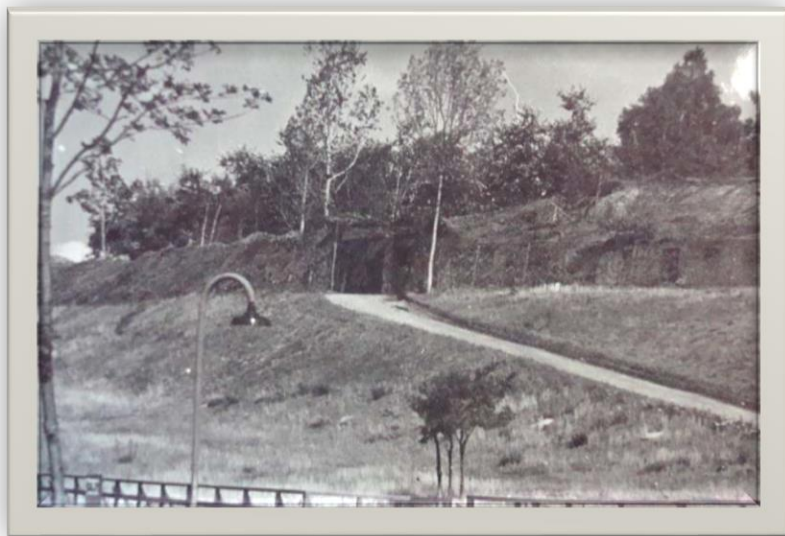
Margival : entrée de l'un des bunkers.
