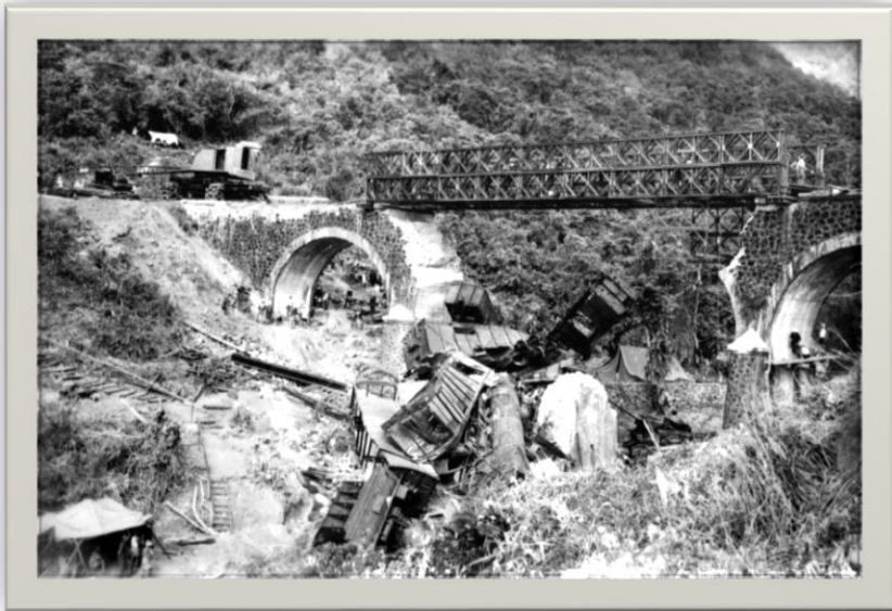
Reconstruction d'un pont Bailey par le Génie moins de 46 jours après sa destruction par l'ennemi. Ce pont fut détruit au moment même où passait un train dont on voit encore les restes.
