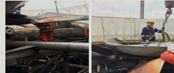
Gambar 6 Pekerjaan penambahan sudu kipas pada menara pendingin
