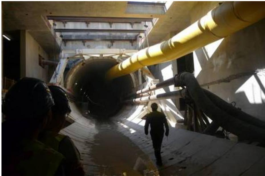
**Figure 4** : Accès au tunnelier par le tunnel creusé. Le tube de grand diamètre alimente l'intérieur du tunnel en air respirable. Les deux autres alimentent la chambre de coupe en bentonite et permettent le retour de la roche de la chambre de coupe vers l'extérieur.
