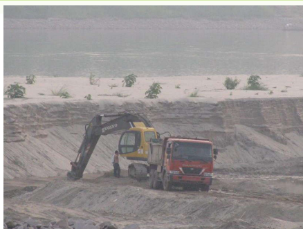
1. Cắt bừa lớp đất và xúc đất vào gầu
