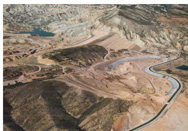
Obras de construcción de una presa en la cuenca del río Segura
