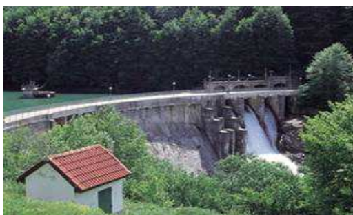
Central minihidráulica en la presa de Irbia (Navarra)
