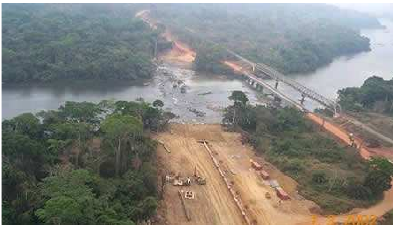
Obras de construcción del oleoducto Chad-Camerún
