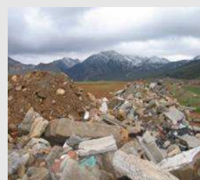
Escombros de una obra
