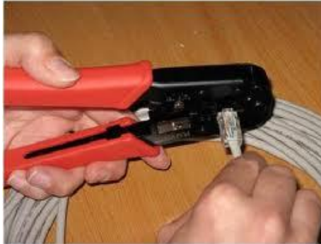
Figura 44. Ponchado del RJ45
