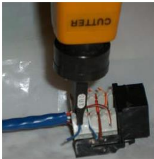
Figura 49. Ponchado del JACK RJ45
