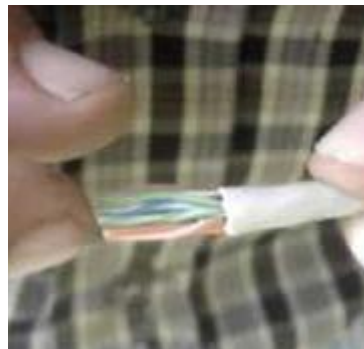
Figura 40. Alineacion de cables
