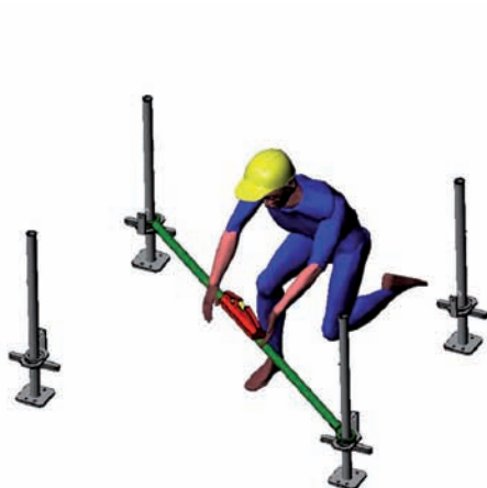
1 Mise en place des vérins et de la diagonale horizontale
