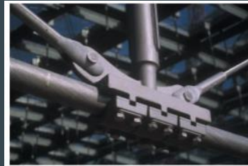
Bild 14. Binderseilklammern Fig. 14. Clamps of girder cables
