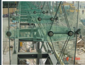
Bild 7. Ansicht der unteren Glasschwerter Fig. 7. View of the glass fins over the portal frame
