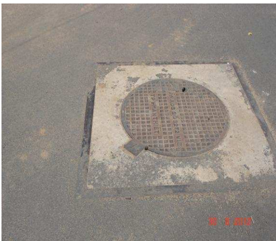
Construction location of Vo Van Tan Road
