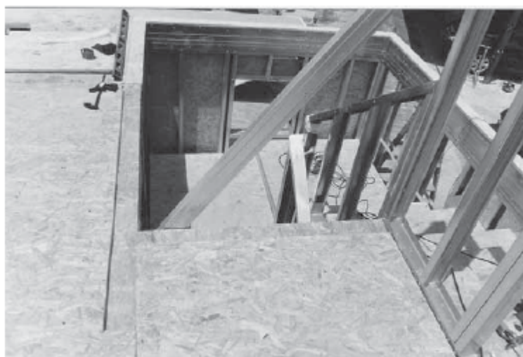
Figura 24 – Placas de OSB utilizadas para laje seca.
