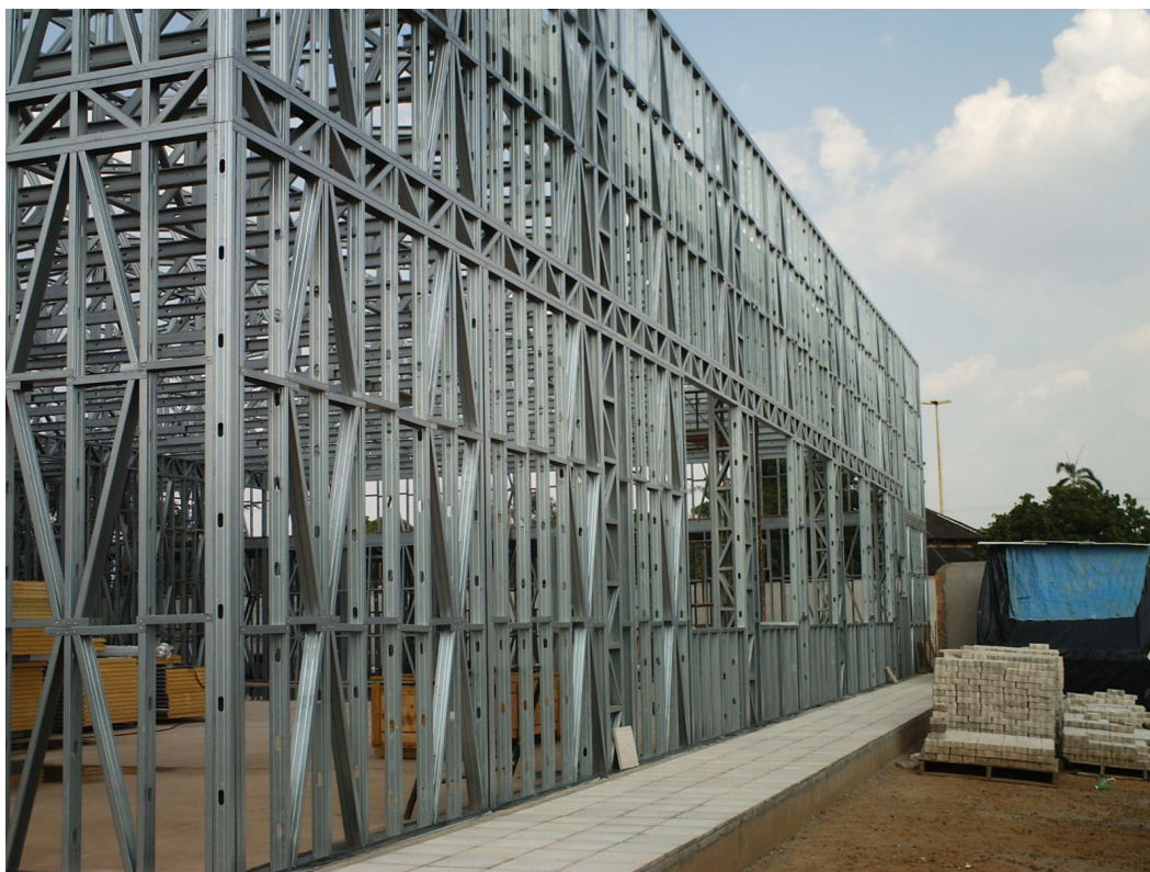
Figura 1: Montagem da obra com Steel Frame
