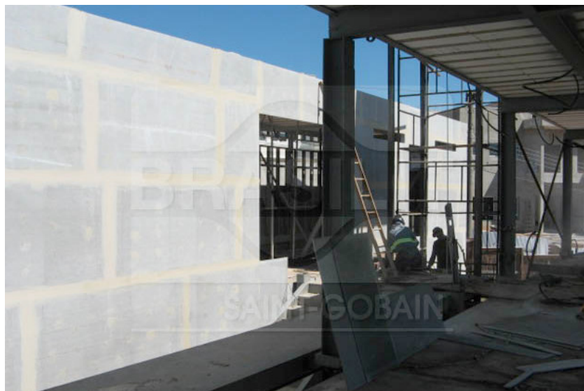
Figura 11: Obra em andamento
