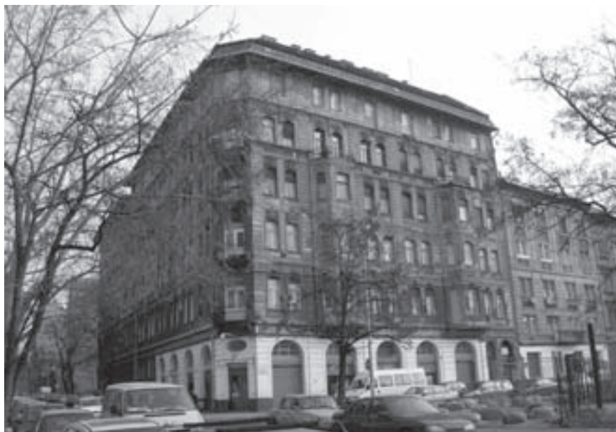
Budapest, immeuble en réhabilitation. Photo : D.R.
