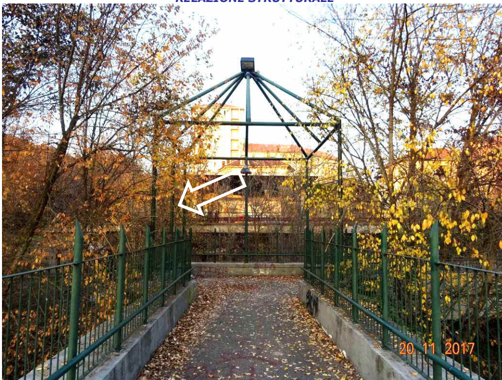
Figura 7-1 – Struttura ornamentale presente sul ponte canale oggetto di modifica. La freccia indica il montante verticale che verrà eliminato per permettere lo sbarco della nuova pista in progetto. (foto: 2379-DSC01238)
